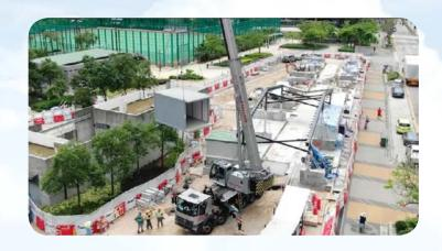
採用「組裝合成」建築法,街市攤檔的 組件先在廠房預製,然後運往工地裝嵌
